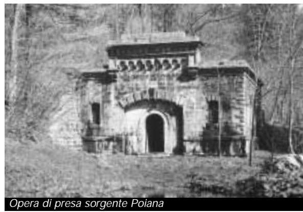
Opera di presa sorgente Poiana
