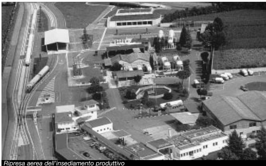
Ripresa aerea dell'insediamento produttivo
