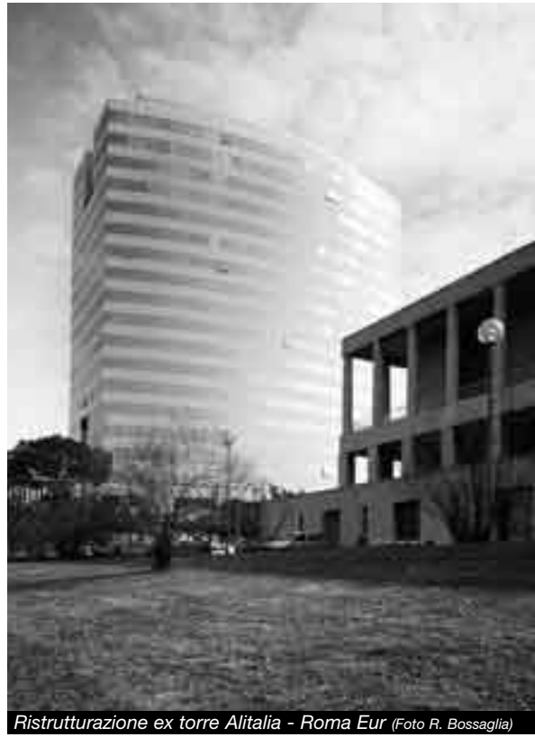
Ristrutturazione ex torre Alitalia - Roma Eur (Foto R. Bossaglia)
