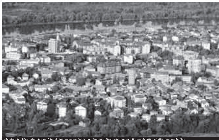
Brcko in Bosnia dove Qnet ha progettato un innovativo sistema di controllo dell'acquedotto
