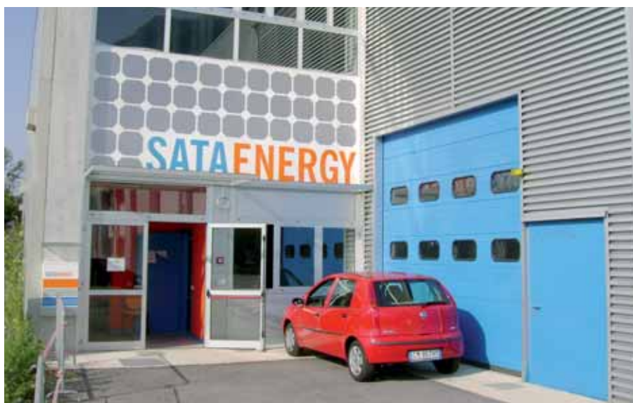
Tra le aziende che hanno trovato posto nel Pip di Bordano c'è anche la Sata Energy
