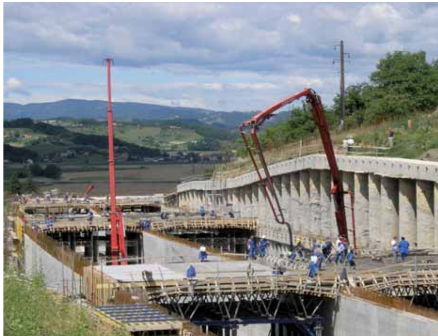
Alcuni lavori in corso per la costruzione in Slovenia del corridoio 5
