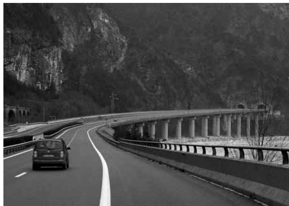
L'autostrada A23 principale asse viario della Valcanale
