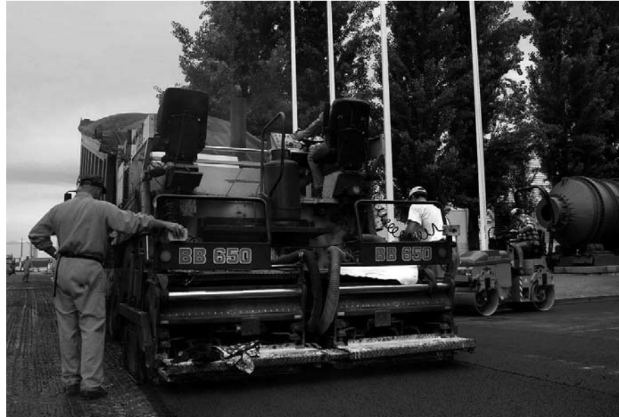
Un esempio di impiego degli scarti di lavorazione dell'acciaio che produce Abs
