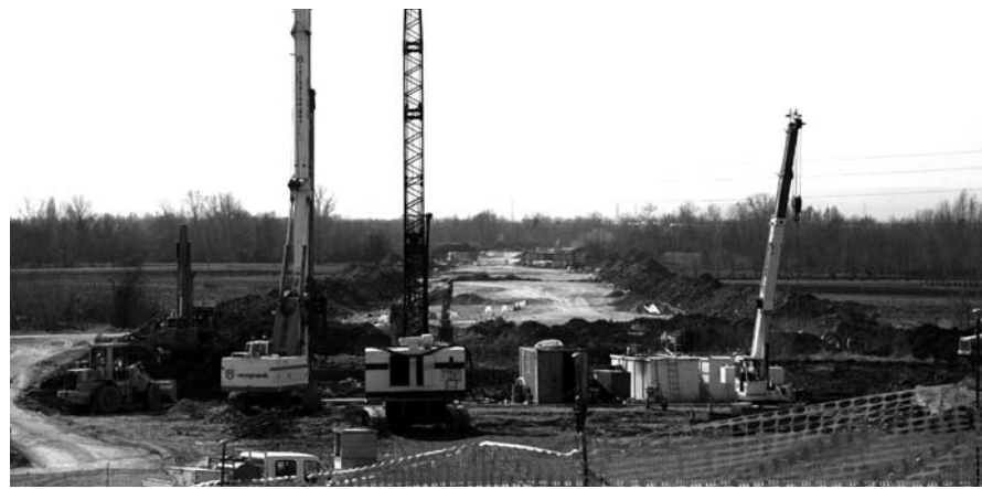
Il cantiere della A28. L'autostrada sarà finalmente completata nell'aprile del 2010
