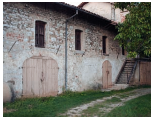
Il primo dei risultati è quello dell'esclusione dall'Ici dei fabbricati rurali
