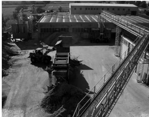
Nello stabilimento di Romans funziona anche una centrale elettrica da 750 kW
