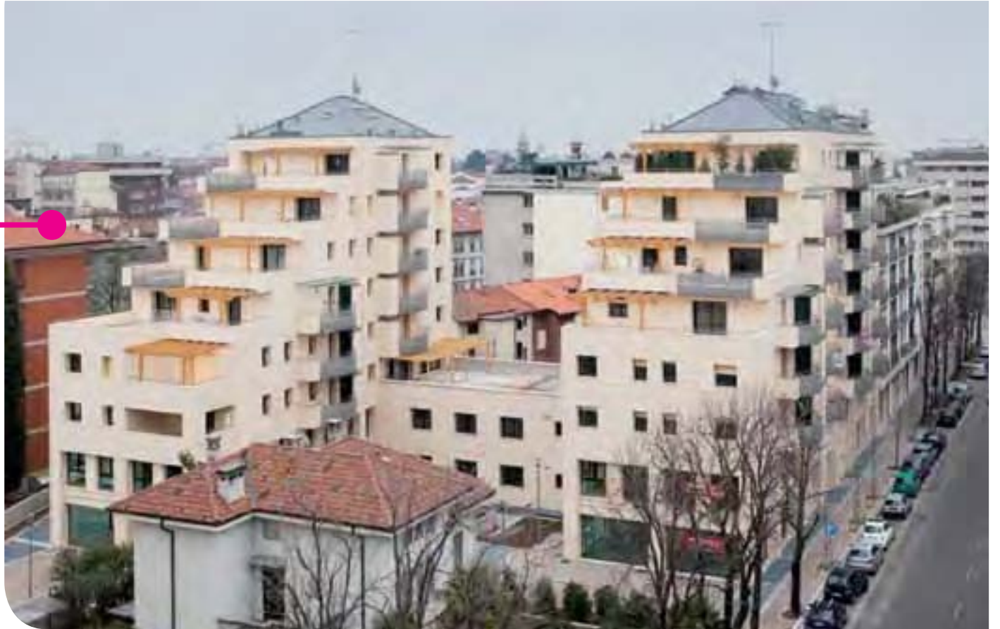
Complesso edilizio a uso residenziale e commerciale sito tra v.le del Ledra e via Marco Volpe a Udine
