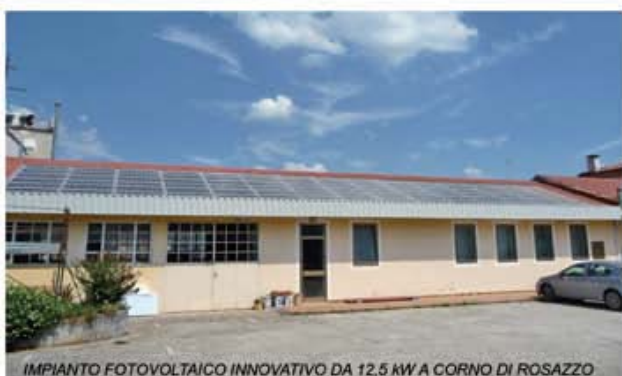
IMPIANTO FOTOVOLTAICO INNOVATIVO DA 12,5 KW A CORNO DI ROSAZZO
