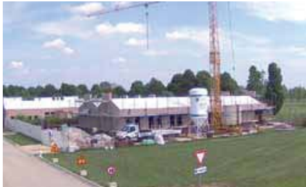
I lavori per l'ampliamento del Parco Tecnologico
