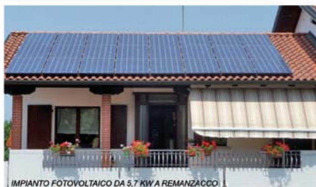
IMPIANTO FOTOVOLTAICO DA 5,7 KW A REMANZACCO
