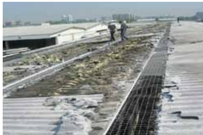
Nelle foto un tetto industriale prima e dopo l'intervento di Benpower
