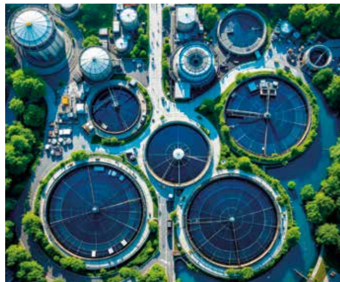
Un impianto di depurazione
